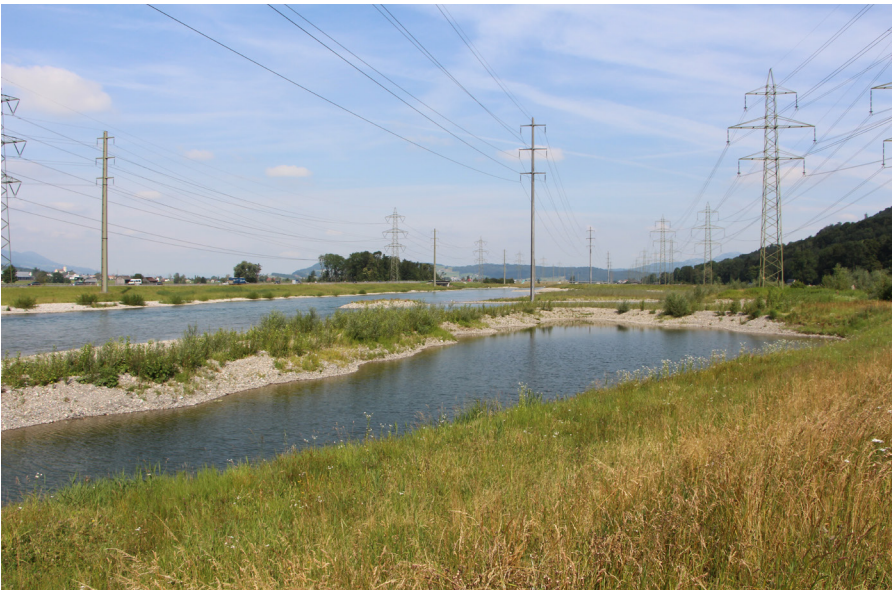
Linthkanal – Hochwasserschutzprojekt mit Revitalisierung im Bereich Hänggelgiessen, Schänis
